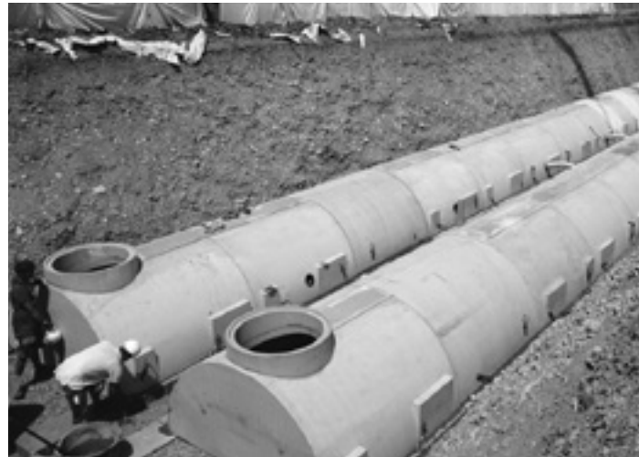
Rigolen als Sickertunnel in Freiburg Foto: Mall GmbH
