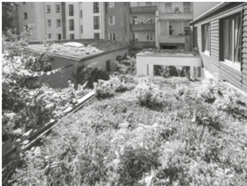
Extensive und intensive Dachbegrünung Foto: Amt für Umwelt- und Verbraucherschutz D
