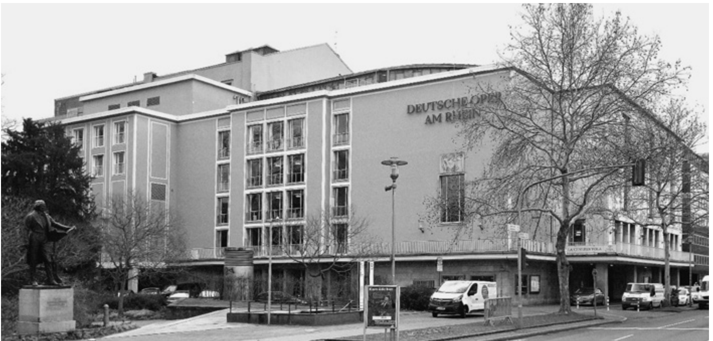
Zweigeteiltes Opernhaus: vorne der Zuschauerbereich, hinten der Bühnenrakt Foto: Hagen Fischer
