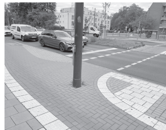
Karl-Geusen-Straße: Mast im Fahrradweg
