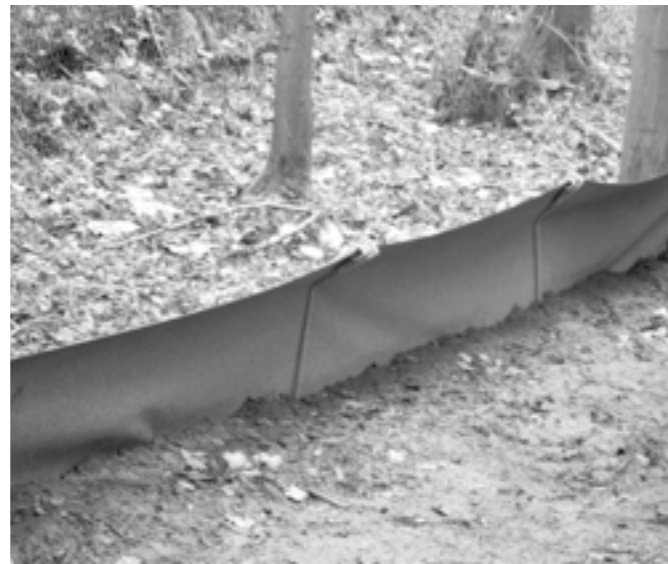
Umleitung durch den Zaun
